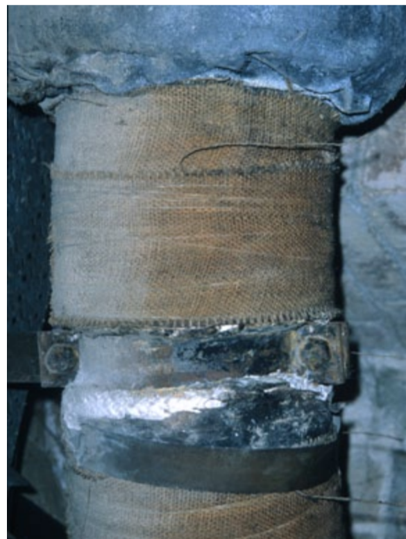
CALORIFUGACIÓ DE CANONADES
